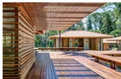
Atentos ao impacto da obra na região e à questão do uso consciente dos materiais, Adriana e sua equipe fizeram uma escolha criteriosa: a madeira local – renovável e de fácil transporte – é o destaque, com o apoio do concreto armado para fundações e lajes de piso e balanços. "Usamos pouca alvenaria devido ao grande índice de quebra de tijolos no transporte", disse.
